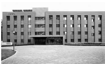
图 4 CABR 近零能耗示范楼落成实景
