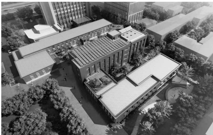
图2 CABR 近零能耗示范楼鸟瞰图
