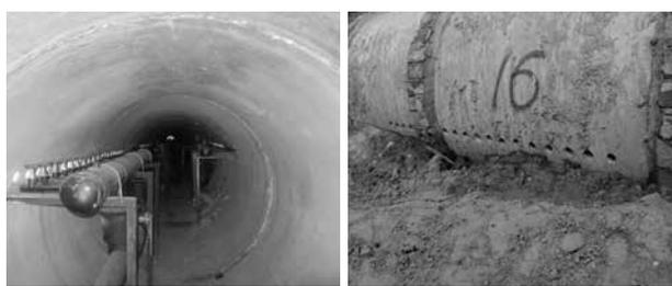
图 6 预制水泥管检查井现场实施场景
