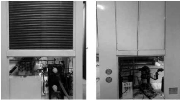
针对样机，对其在典型工况下的性能进行了测试，测试工况为：室外干球温度 2℃，相对湿度 85%，机组进水温度 40℃，水流量 1.6m<sup>3</sup>/h。开机运行 115min 后，喷淋浓度为 7.8% 的甲酸钠溶液进行除霜，除霜时长 5min，除霜结束后溶液浓度为 6.8%，之后进行冷冻再生。冷冻再生过程中溶液浓度、温度、机组吸、排气压力、制热量和 COP 随时间的变化关系如图 6~10 所示。
