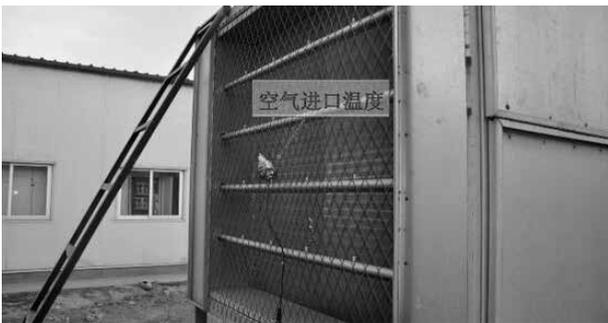
图 2 热源塔空气进口温度测点布置图
