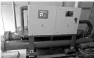
图 14 二次侧高温热泵机组
