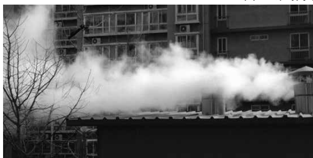
图3 烟气源热泵系统没运行时烟气排放
