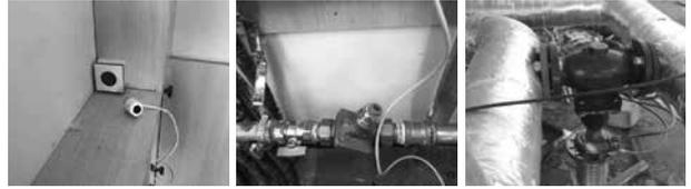
图 2-3 温控器 图 2-4 AB-QM 阀 图 2-5 压差旁通阀
