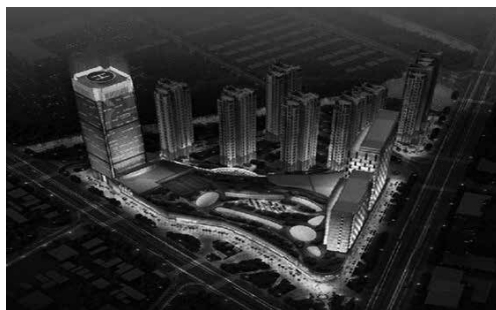
(a) 银泰城实际外观图
