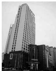
图 1 该综合楼建筑实拍图
