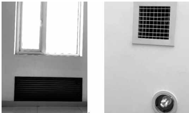
图 3 置换通风系统的送、回风口
