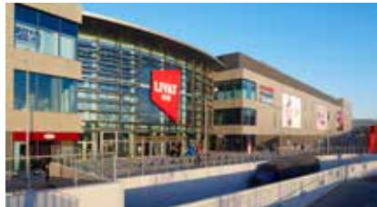
北京英特宜家购物中心大兴项目二期工程
