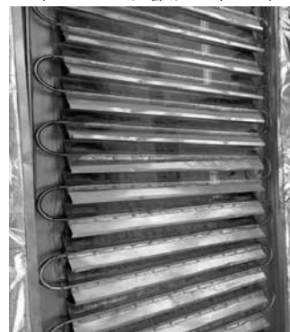
图 5 蓄能炕内部构造图
