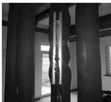
图 9 超声波流量计探头
