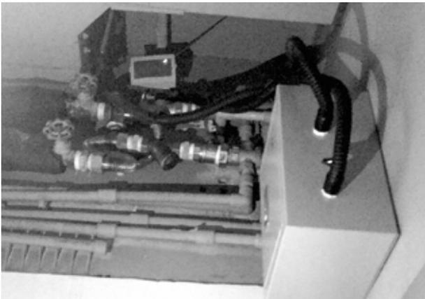
图 11 毛细管网末端控制箱
