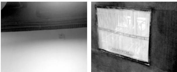
(a) 壁面毛细管网 (b) 地面毛细管网
