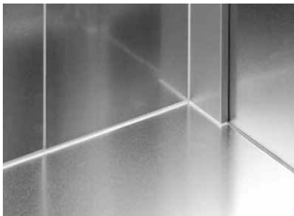
图 2 箱体接缝硅胶密封
