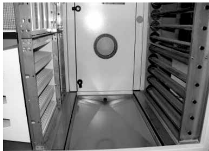
图 1 不锈钢大坡度凝水盘
