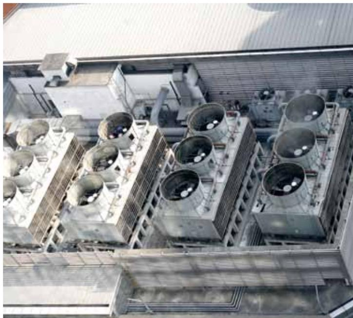
中央空调冷却水在夏季制冷空调运行时，冷却塔风扇将建筑物的周边大气抽入到冷却塔内与冷却水进行湿湿交换，冷却塔一般装在建筑物屋顶。这个过程其实就是对周边大气进行增湿升温，从冷却塔风扇出口排出的含有亚硝酸钠的湿空气是以每秒4米~6米向外抛出的。
