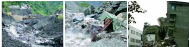
地震导致的地面破坏 山体等自然物的破坏 建筑物和构筑物的破坏
