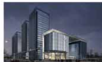
交通银行扬州数据中心
