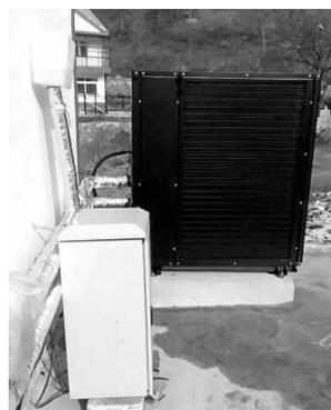
图 3 R32 空气源热泵主机及数据监测系统
