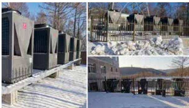
应方面均得到认可，成为区域市场热泵清洁供暖的示范项目。据悉，黑龙江正法寺和普渡寺供暖项目所使用的热立方 EVI 一体机组采用喷气增焓压缩机，显着提升了低环温的制热效果，采暖温度均能达到 20 以上，为寺庙提供了稳定的采暖环境，不仅在运行成本上更低，制暖效果也比传统更好。
